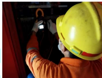
Gambar 28 Pengecekan Inverter
