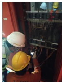
Gambar 27 Pengukuran Tegangan dan Arus
