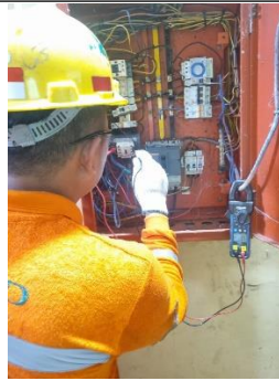
Gambar 29 Pengecekan MCCB
